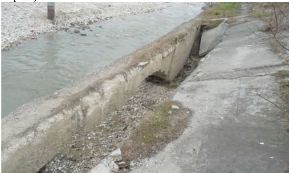
Рисунок 1 – Разрушенный участок откосного крепления с упорным брусом р. Нальчик в результате размыва русла и фильтрационных деформаций грунтов
