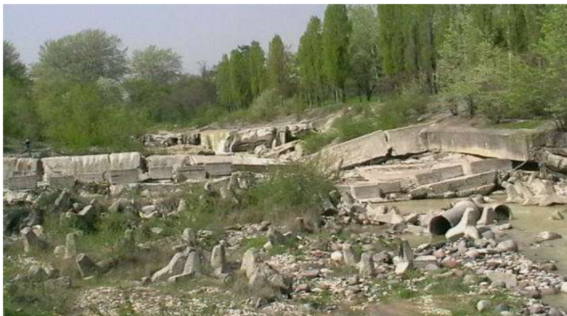
Рисунок 2 – Разрушенный железобетонный перепад р. Нальчик с прибрежными креплениями.
